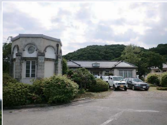
手前：出水井上屋／後ろ：水道記念館
